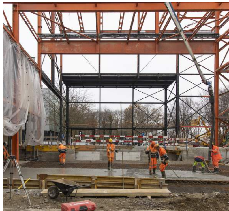
Chantier de rénovation du Théâtre de Vidy, novembre 2020. © Odile Meylan/24 Heures
